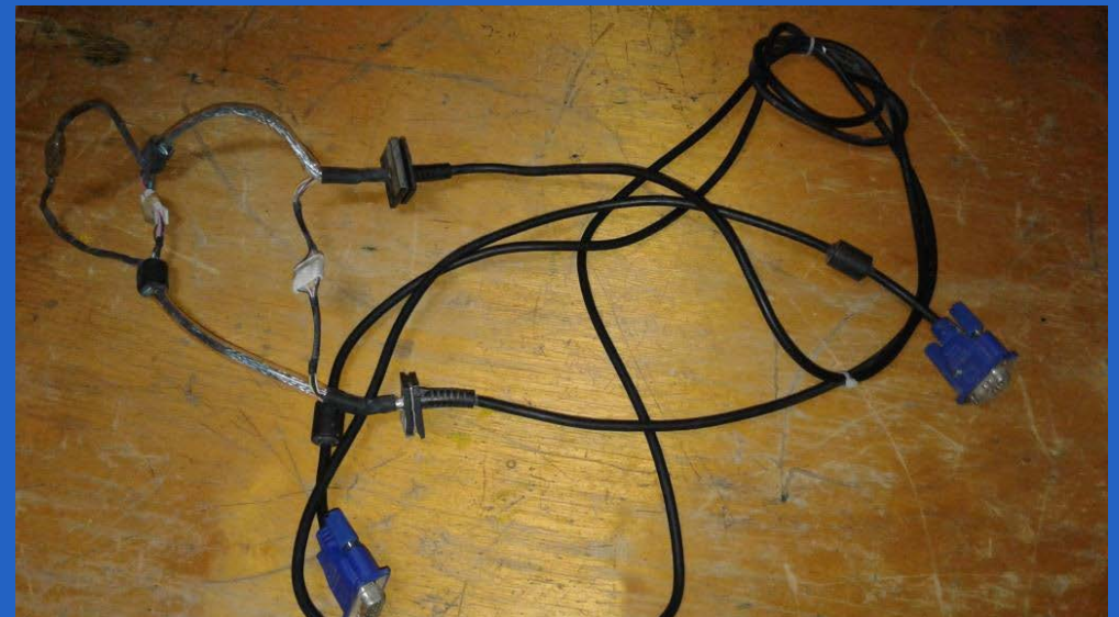
Figura 2. Proceso de empalme de los cables.
